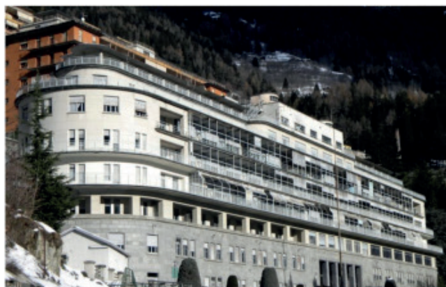
Vista in primo piano dell'Ospedale Morelli
